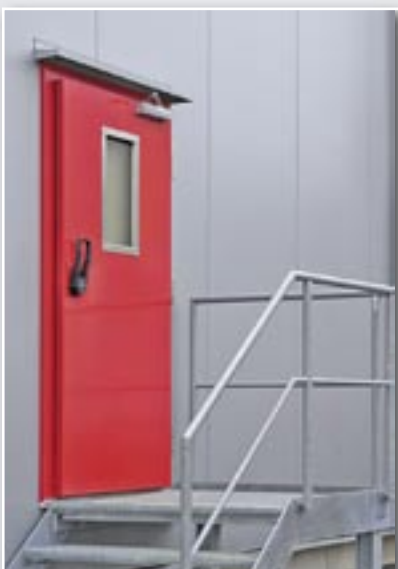
Bild links: Fluchttüre aus dem Kühlhaus, mit Sichtfenster, Obentürschließer und Wetterschutz
