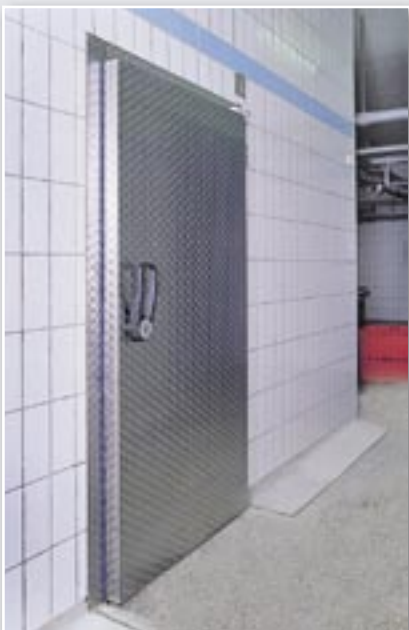
Bild links: Tiefkühlraumdrehtüre, eingebaut in ein Mauerwerk
