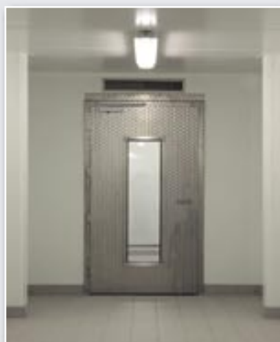
Bild oben: Betriebsraumdrehtüren in einer Molkerei. Tür, Flügel, Zargen und Beschläge wurden in korrosionsbeständigem Edelstahl erstellt.
