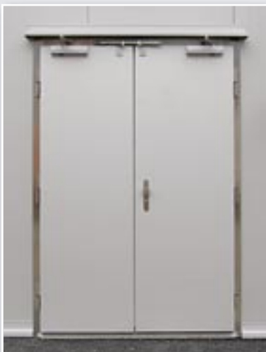
Bild oben: Betriebsraumdrehtüren in einer Molkerei. Tür, Flügel, Zargen und Beschläge wurden in korrosionsbeständigem Edelstahl erstellt.
